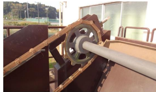
図 2.4 自動除塵機チェーン
