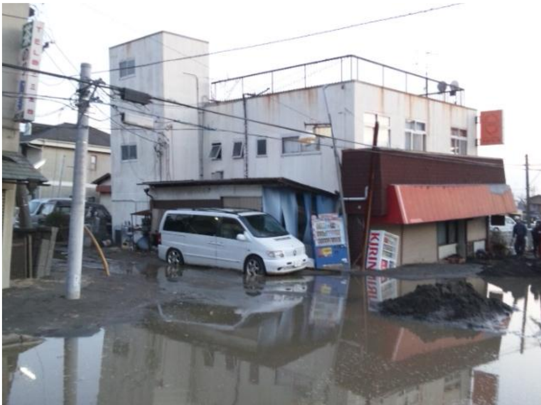
(電柱、家屋の被害状況)
