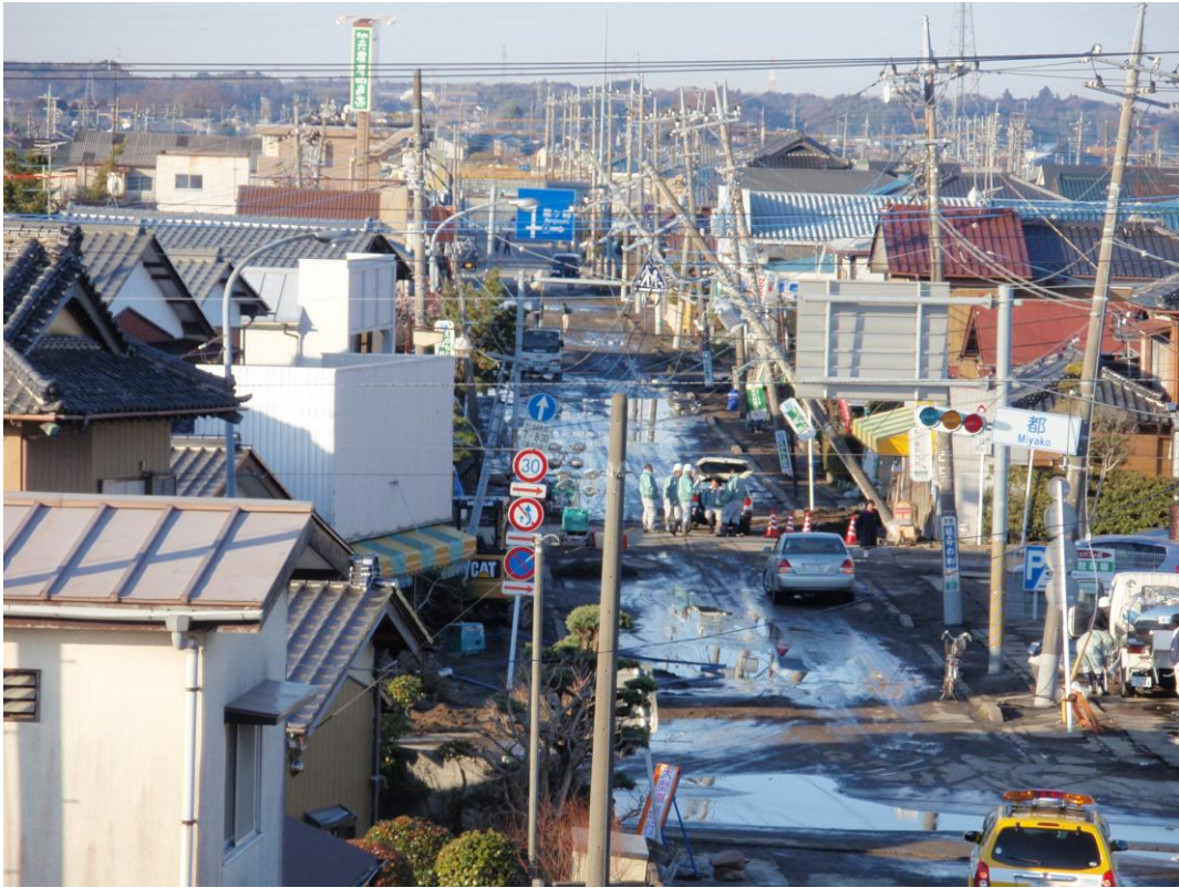
(幹線道路周辺の被害状況)
