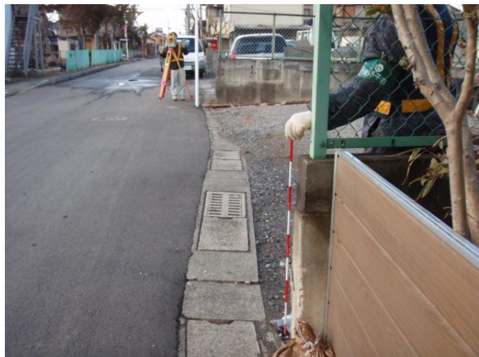
(道路境界の調査状況)
