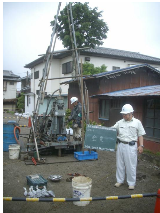
(ボーリング調査)
