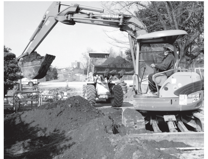
▲我孫子第一小学校での除染作業
