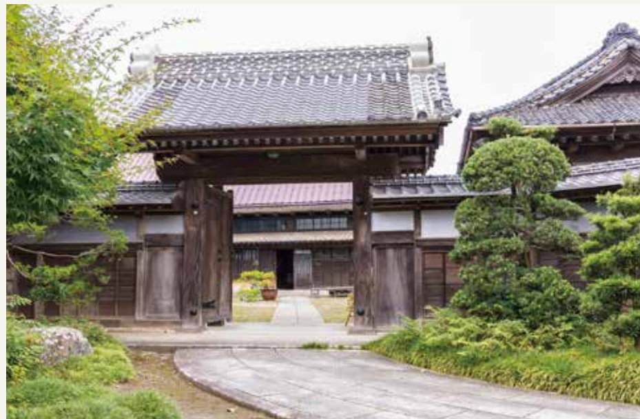
修缮后的正门精工细雕。使用了建筑物原有的瓦片和柱子,只补充了不足部分。请鉴赏意匠的精致。
