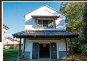
昭和初期建造的新土藏。使用了当时最先进的技术。
