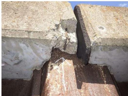
図 3.4-2 老朽化した雨水排水路
