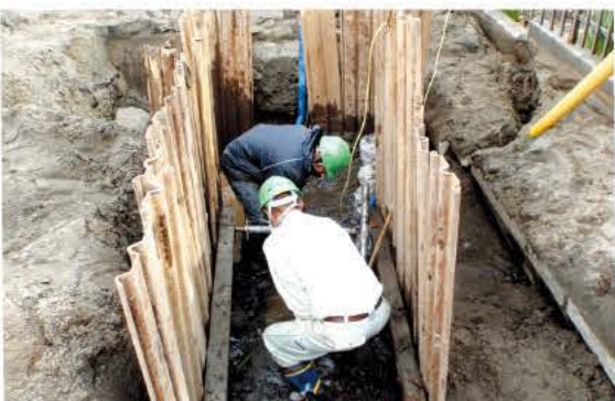
復旧工事の様子
