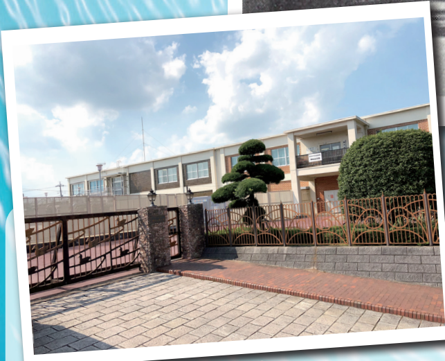
現在の湖北台浄水場(管理棟)
