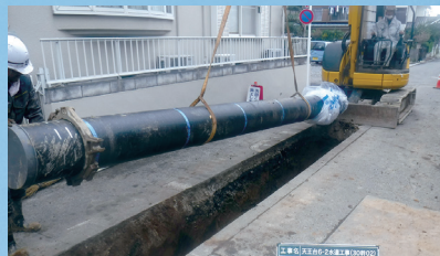
▲耐震管布設状況
