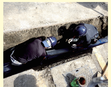
ダクタイル鋳鉄管(GX)口径150mmの布設替え状況
