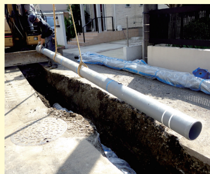
ダクタイル鋳鉄管(GX)口径150mmの布設替え状況
