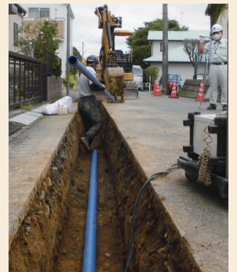
▲耐震性に優れた管(水道配水用ポリエチレン管)に取り替えている様子
