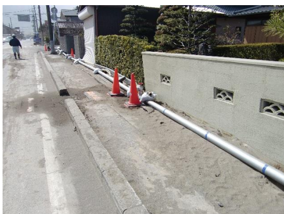
応急復旧による仮設配水管路
