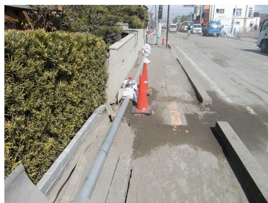
応急復旧による仮設配水管路
