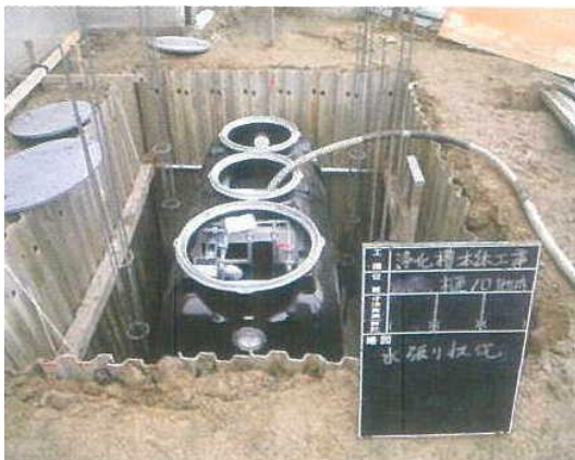
【写真 4】据付工事の状況を示す写真
