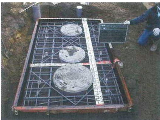
【写真6】上部スラブ工事を示す写真
