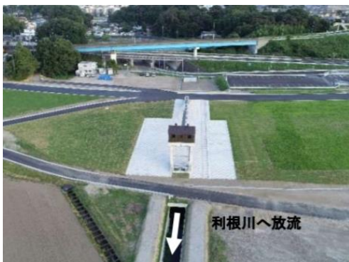
排水施設（後田樋管）
