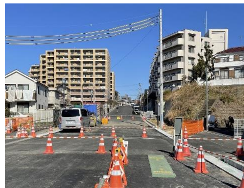
整備中の都市計画道路(手賀沼公園・久寺家線)
