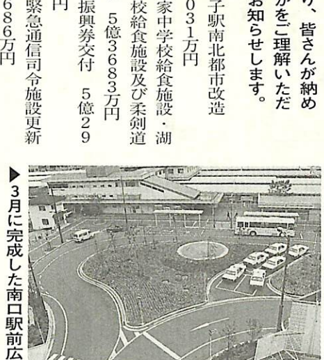
▶3月に完成した南口駅前広場 ◎我孫子駅南北都市改造 10年度は、我孫子駅南口駅前広場の整備などを行いました。
