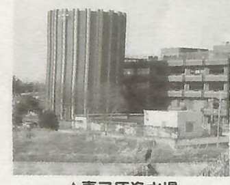
▲妻子原浄水場
