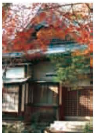
▲再整備が予定されている旧村川別荘
