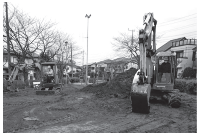
▶表土の削り取り作業(つくし野2号公園)
