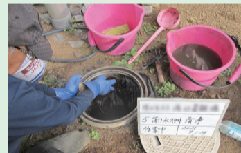
▲雨水桝の除染作業
