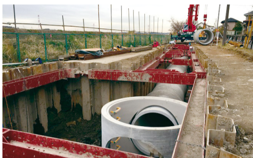
▲若松地区の工事
