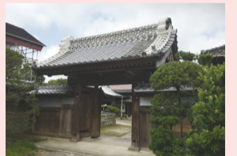
▲保存整備工事が完了した表門
