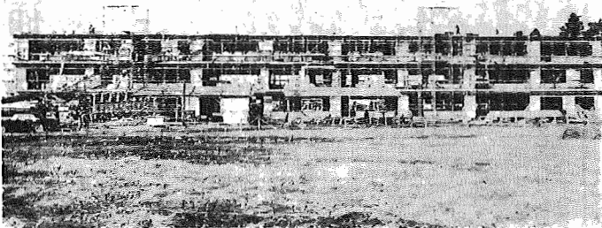
新築工事進む湖北台西小学校
