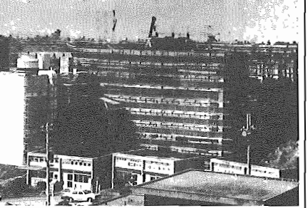
●今秋オープンをめざし建設中の市民会館
