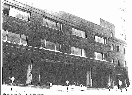
●生まれ変わった消防庁舎
