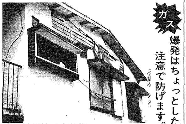
●先日、市内で起きたLPGガス爆発現場
