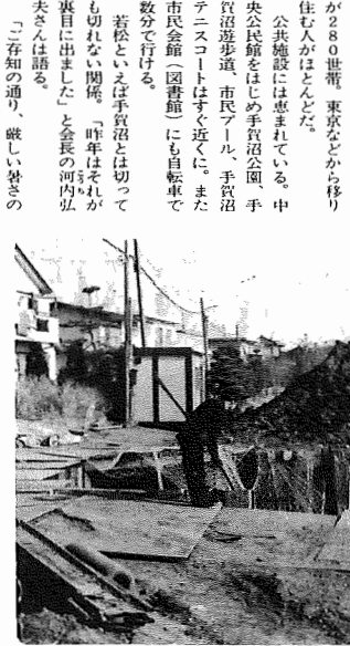
若松の内水排除ポンプ工事も急ピッチに
