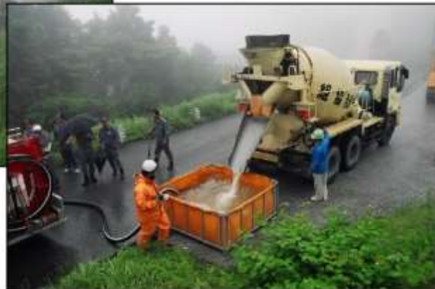
(写真提供：高知県生コンクリート協同組合連合会)
