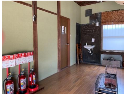
トイレ入口付近
