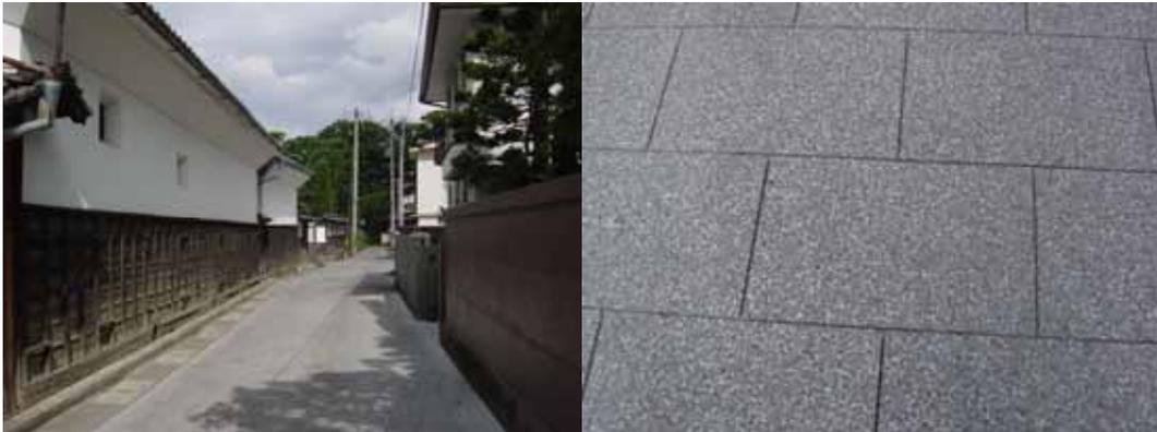
半たわみ化粧仕上げ舗装（石畳風アスファルト舗装）
